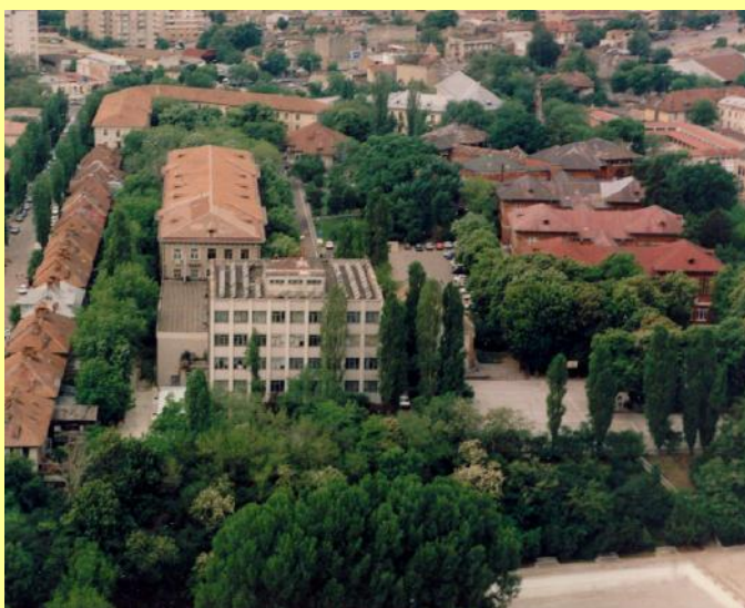
Fig. 1 Academia Tehnică Militară – vedere generală
